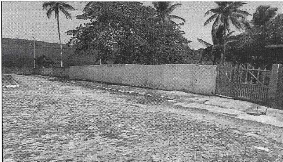
Fig. 7 – Situação da pavimentação do local de acesso ao futuro Parque (Setembro, 2021)
