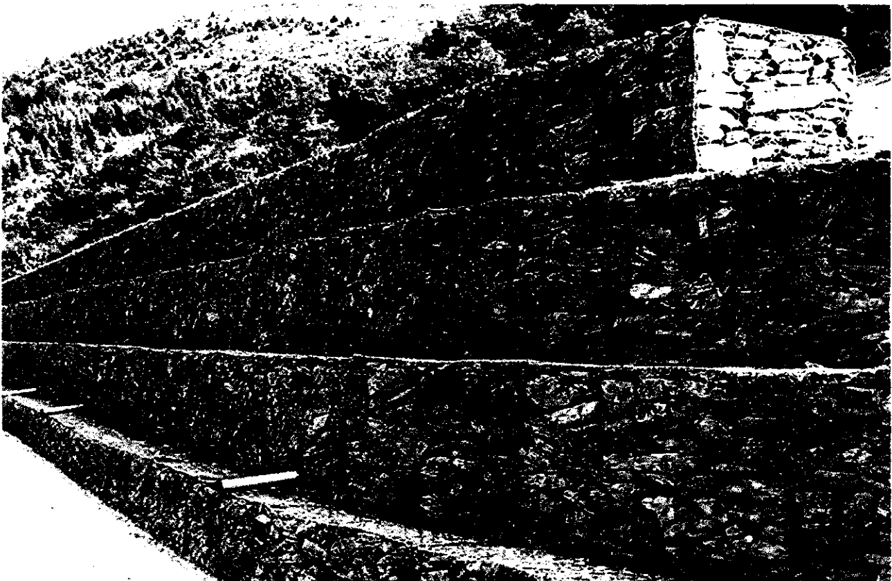
Figura 5 –Contenções – Gabiões.
